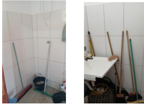
Descrição dos serviços
