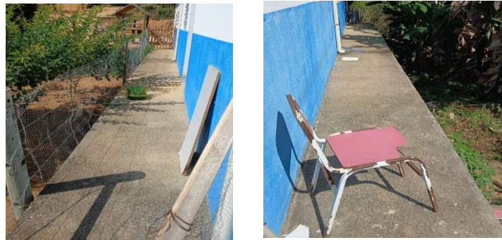
Descrição dos serviços
